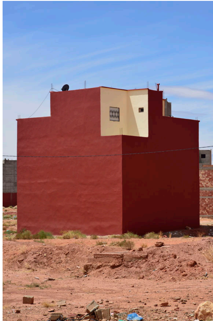
11 - Nouvelles construction 2016 Tinghir Maroc
