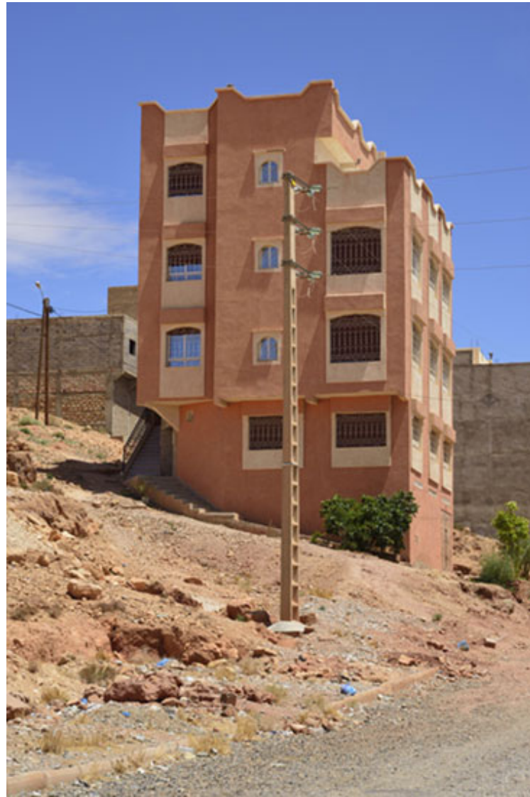
36 - Nouvelle construction 2016 Tinghir Maroc
