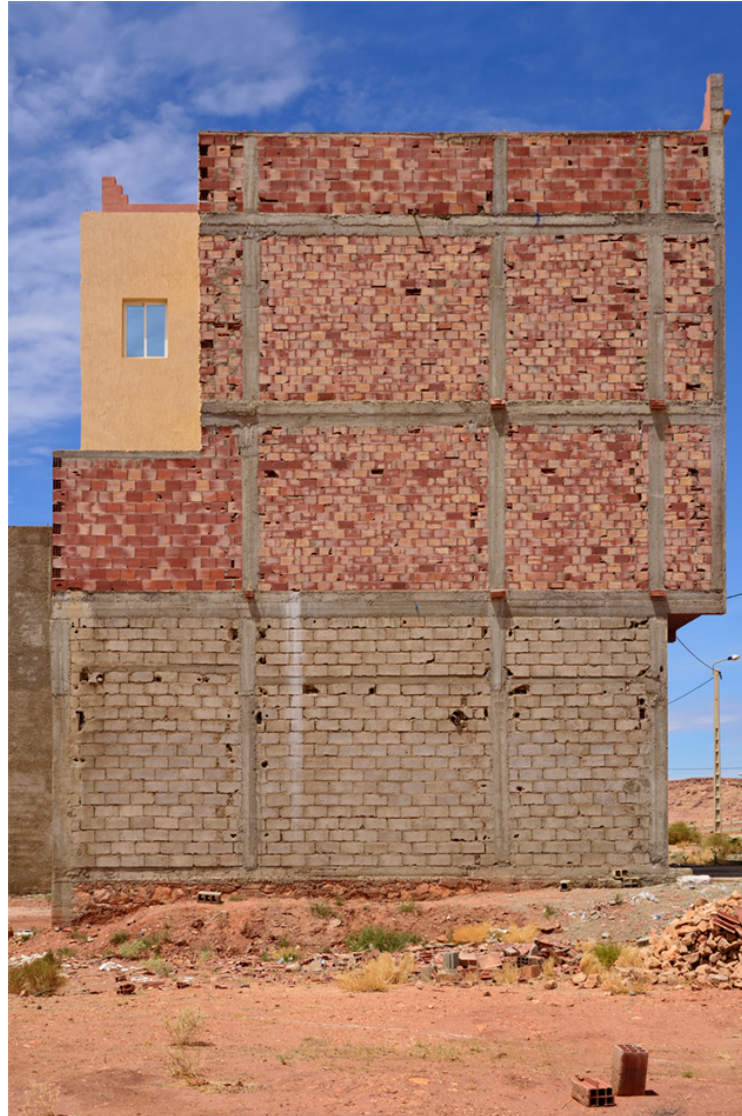
26 - Nouvelle construction 2016 Tinghir Maroc
