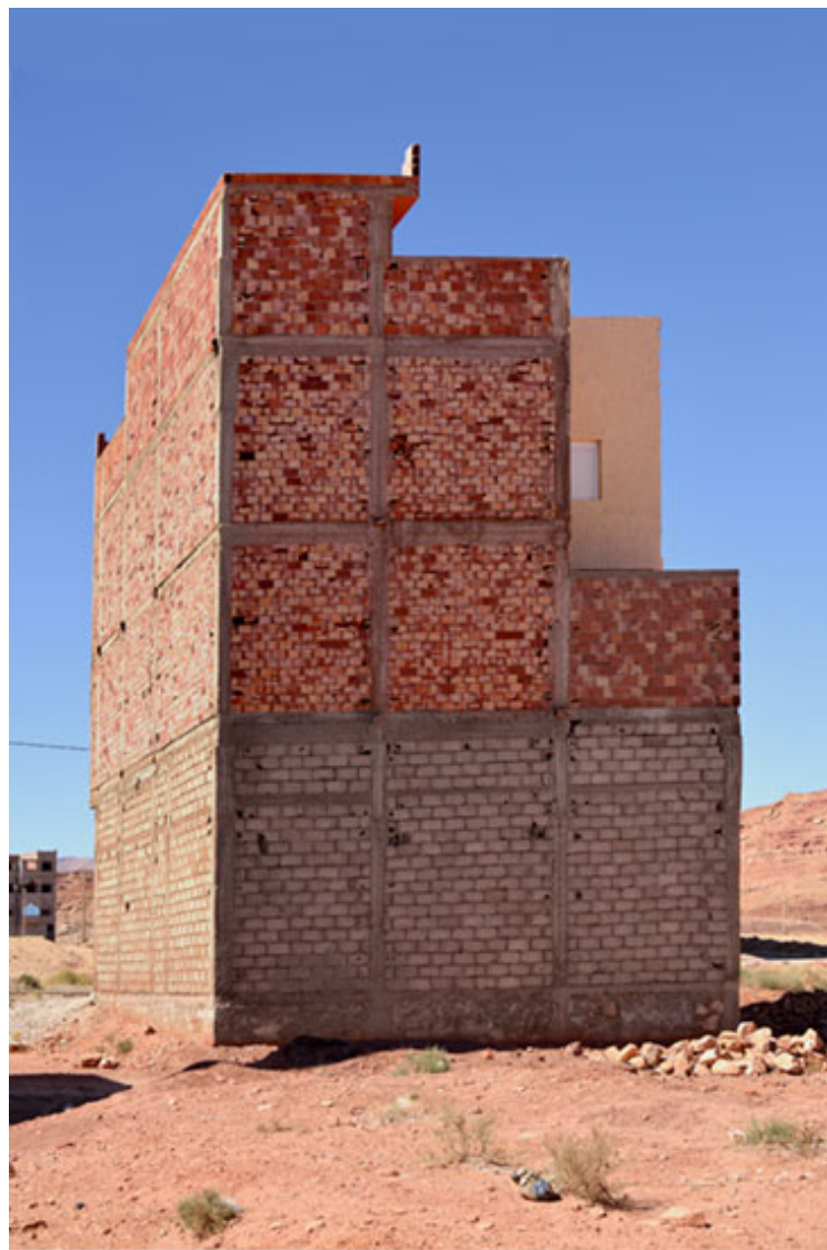
22 - Nouvelle construction 2017 Tinghir Maroc
