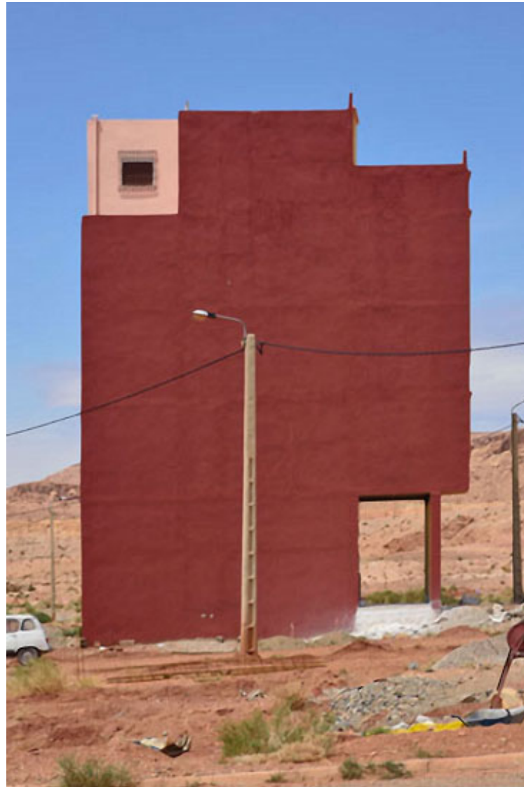
24 - Nouvelle construction 2016 Tinghir Maroc
