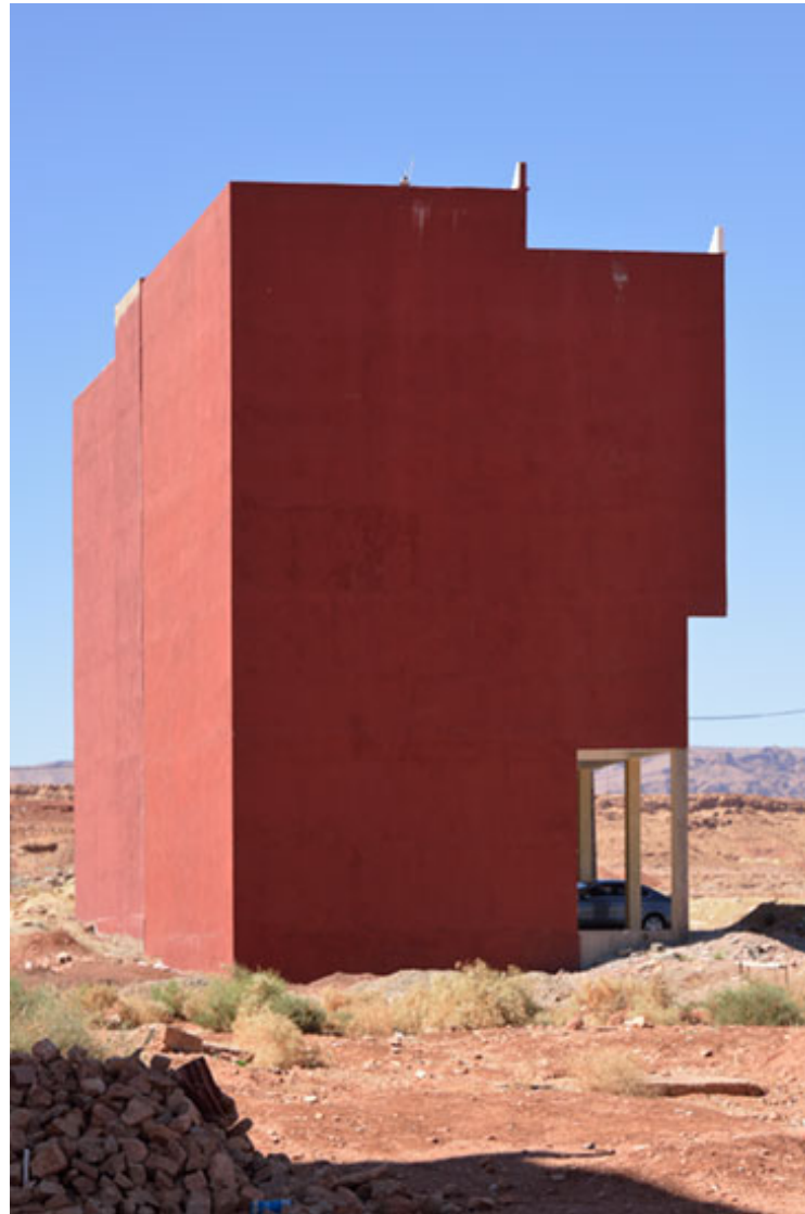
23 - Nouvelle construction 2017 Tinghir Maroc
