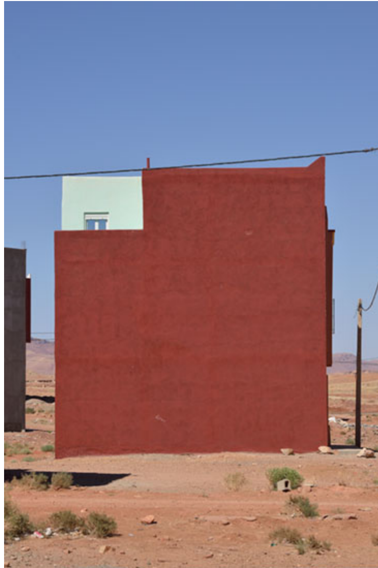
10 - Nouvelle construction 2016 Tinghir Maroc
