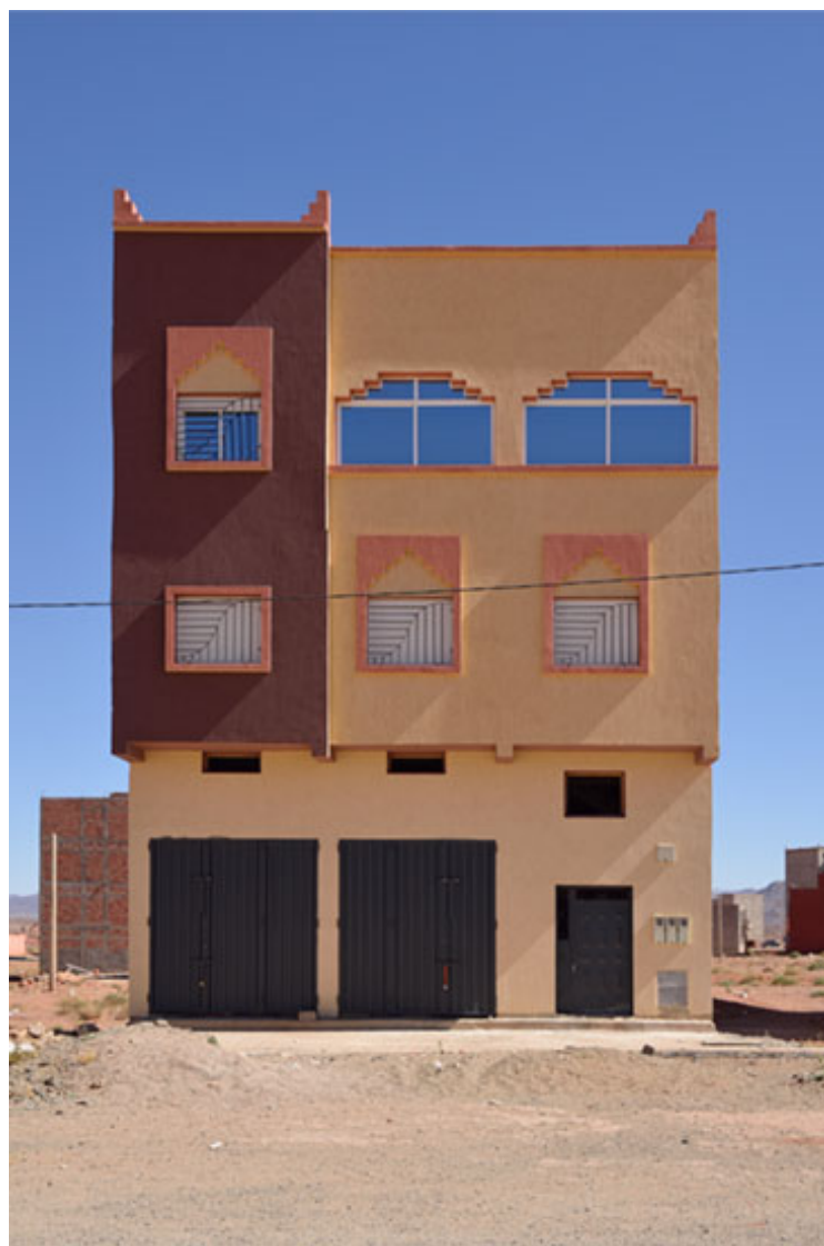
25 - Nouvelle construction 2017 Tinghir Maroc
