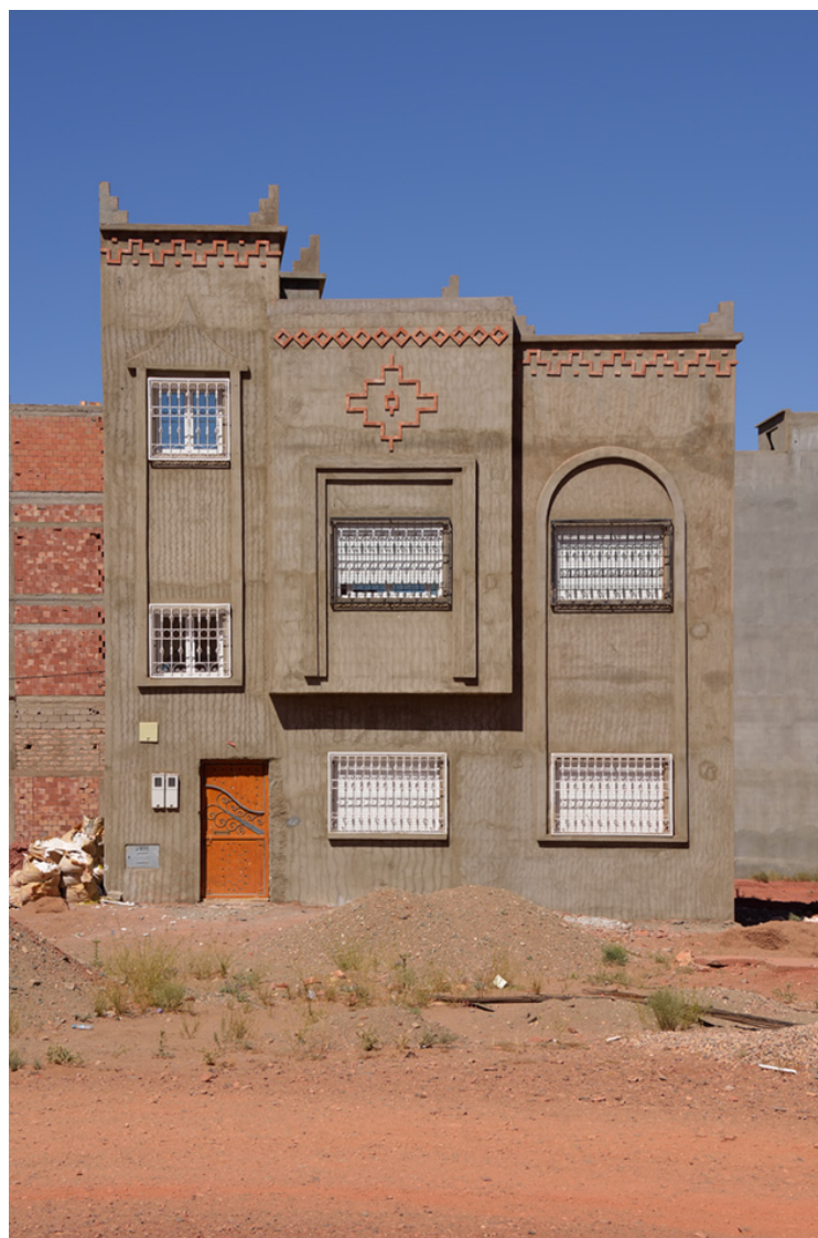
21 - Nouvelle construction 2016 Tinghir Maroc
