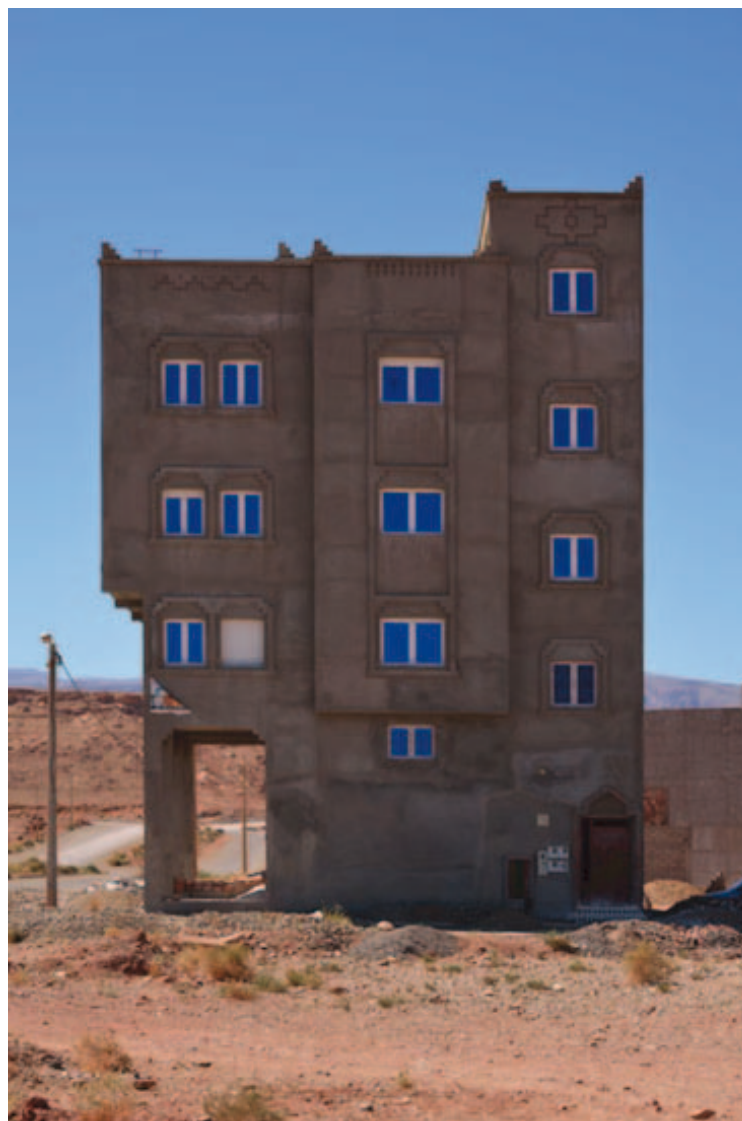
20 - Nouvelle construction 2017 Tinghir Maroc
